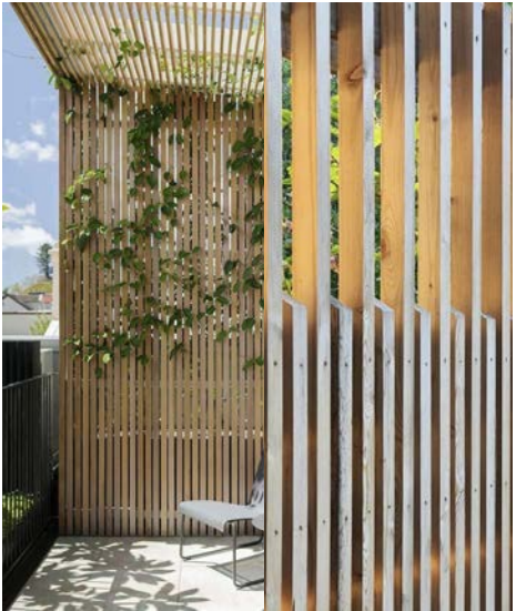
Träribbor med klätterväxter vinkelrätt ut från fasaden markerar entréer och skapar vindvång.
